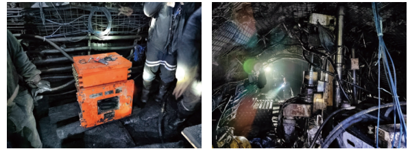
(a) 电控箱定位及通电 (b) 钻孔施工
